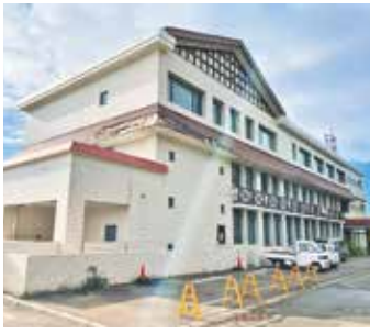
被害を受けた本庁舎
