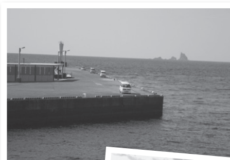
伊ヶ谷港棧橋
