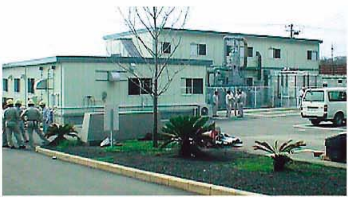
役場駐車場内に建設された脱硫宿舎
