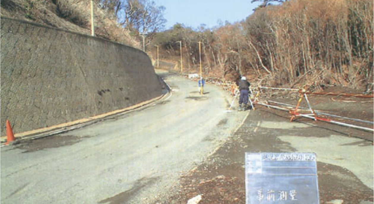
坪田地区大沢にて泥流で崩壊した都道の復旧工事
