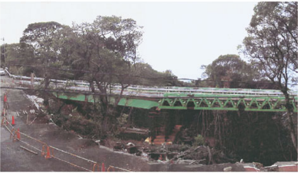
9月末に完成した長さ64mの空栗橋仮橋
