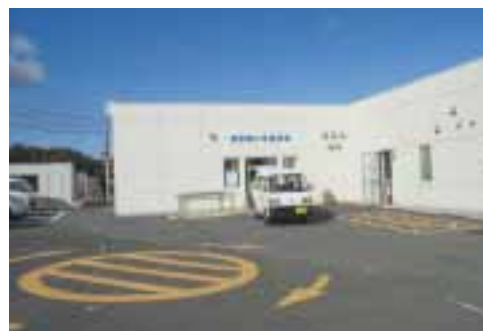
平成20年春の空港再開に向けた整備
