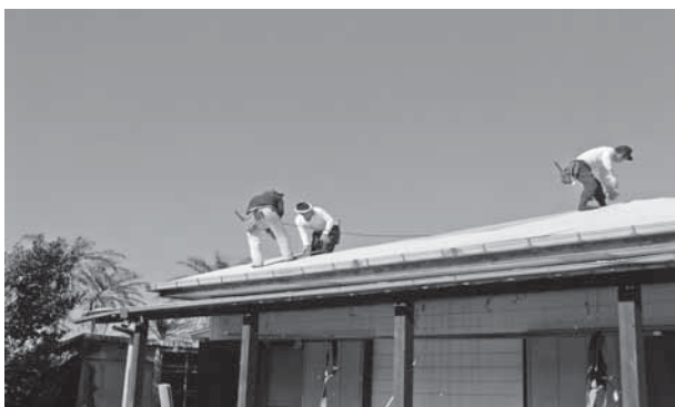
写真 屋根修理
