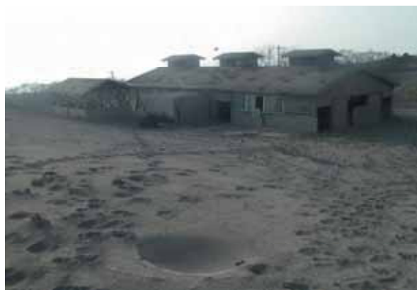
2000.8.20 撮影 降灰・噴石被害(村営牧場)
